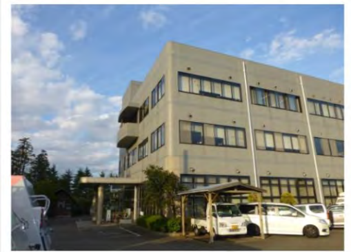
総合リサイクルセンター プラザ棟
